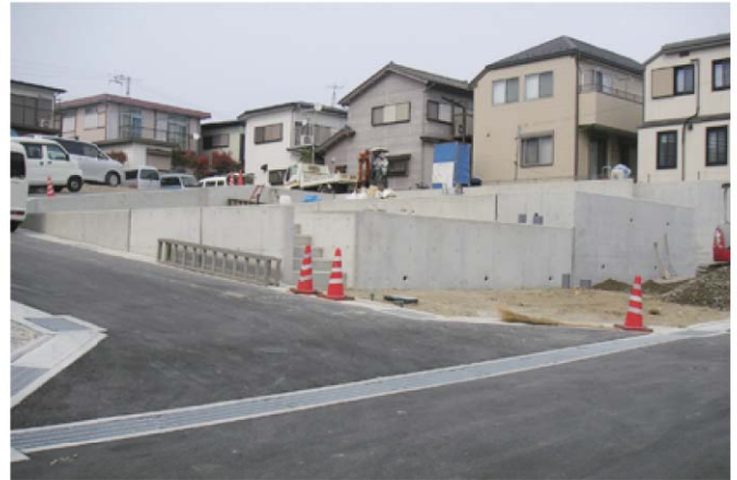
傾斜地や崖地など「クセのある用地」を企画力と設計力で造成し、建物まで一貫施工するトータルプランニングで成長を続けている
