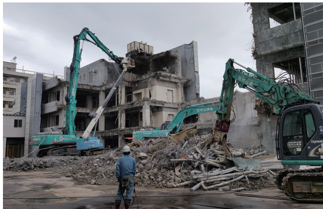
木造民家の解体から公共施設の大規模解体まで地域トップクラスの機械・機動力で対応する
