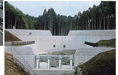
富士山砂沢第一砂防堰堤工事
