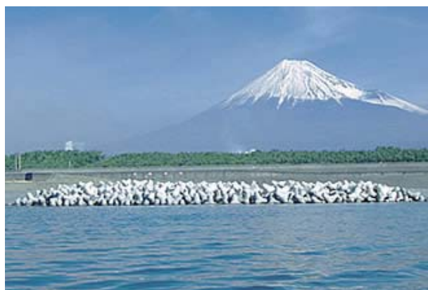
富士海岸吉原地区 6号消波堤災害復旧工事
